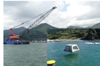
藻場の造成工事(八峰町)
