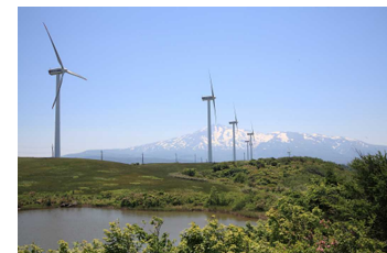
仁賀保高原の風力発電(にかほ市)
