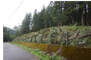
緩衝地帯整備後(湯沢市)
